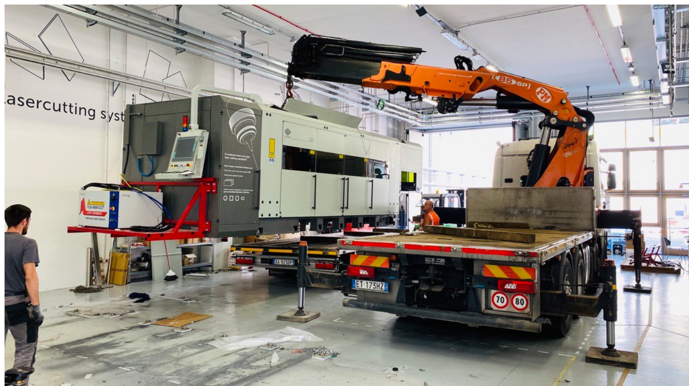
Fasi di installazione della macchina taglio laser fornita da Adige SpA.
